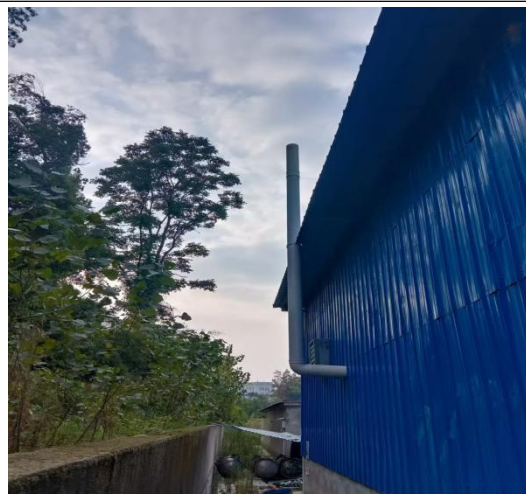
酸雾吸收塔废气排气筒
